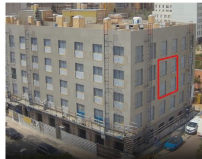
Arquitectura: EXE Vivas arquitectes
